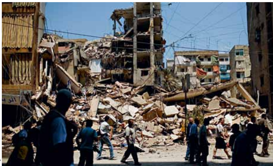
Рис. 19.2 Обрушение здания — часто наблюдаемый результат взрыва бомбы.
